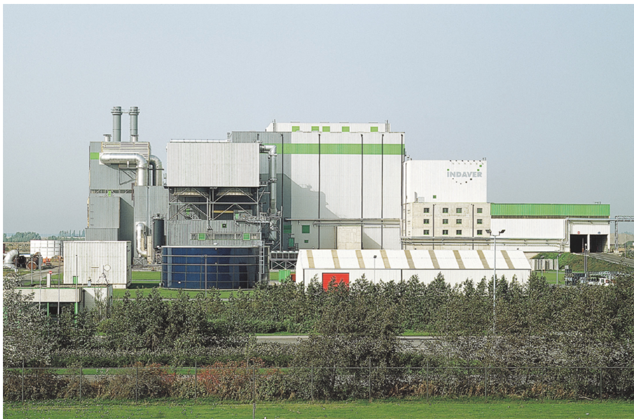
Figure 16 : Incinérateur de déchets dans le port d'Anvers, Belgique (Crédit photo : Indaver, Belgique)
